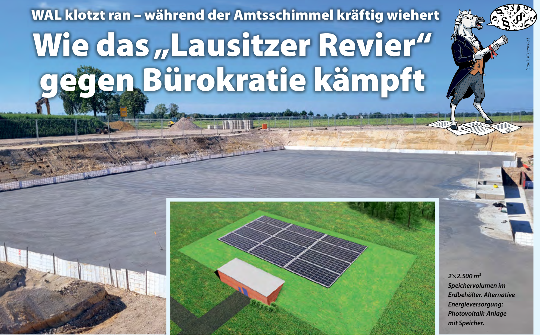
Geschafft: Die sogenannte Sauberkeitsschicht für die zukünftige Druckerhöhungsstation Allmosen ist eingebaut. Bald geht es mit den Erdbehältern fürs Trinkwasser los. Ans Netz gehen sollen diese und die Druckerhöhungsstation in Lauchhammer-Ost im Herbst 2027.
