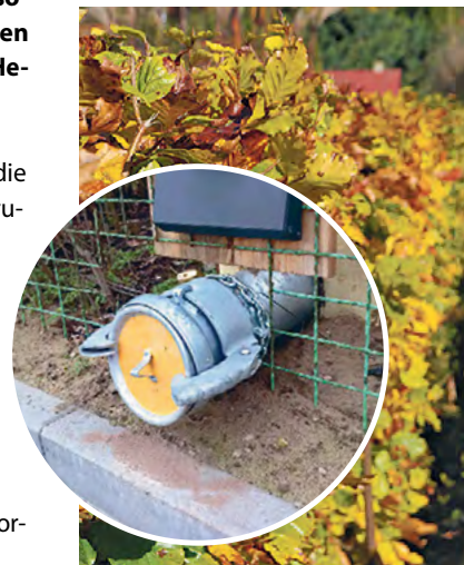
Der perfekte Saugstutzen: straßenseitig gut erreichbar.
