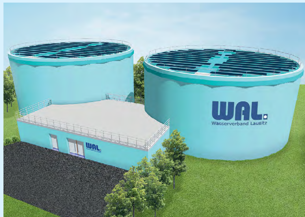
2 x 2.500 m³ Speichervolumen. Alternative Energieversorgung: Photovoltaik-Anlage mit Speicher.
