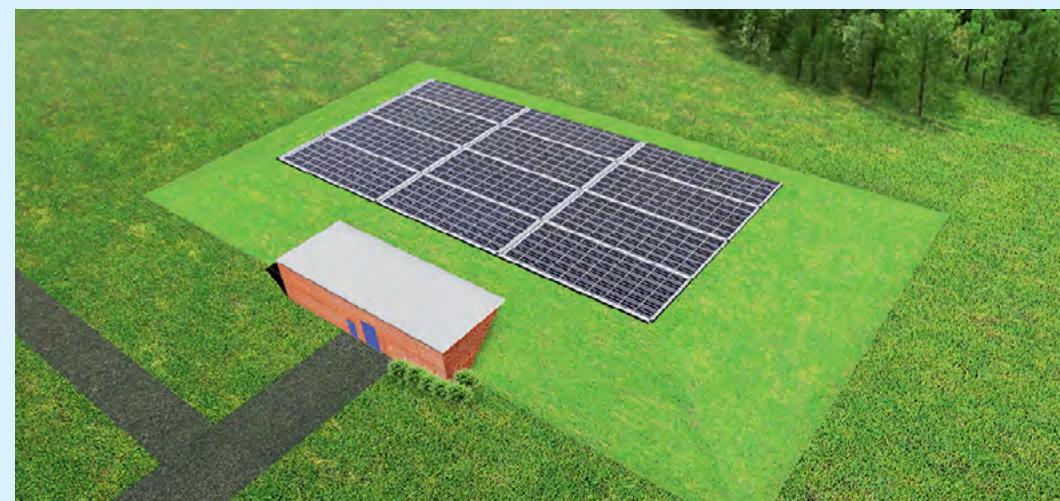
2 x 2.500 m³ Speichervolumen im Erdbehälter. Alternative Energieversorgung: Photovoltaik-Anlage mit Speicher.
