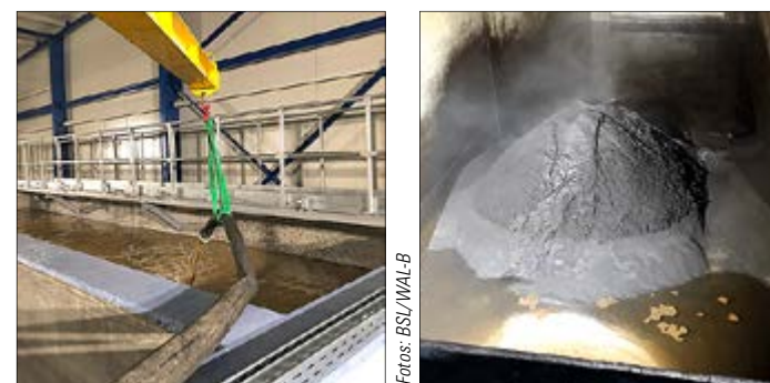
Szenen des Austauschs von Filtersand im Wasserwerk Tettau.
