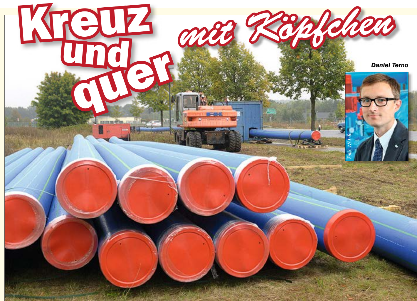
Nah der B96 warten die Kunststoffrohre auf ihre Verlegung als neue Verbindungsleitung Lauta-Dorf–Großkoschen. Foto: SPREE-PR/Rasche
