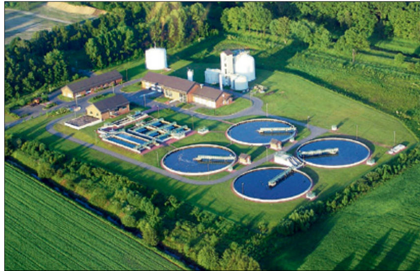
Die Kläranlage Brieske ist eine technologische Perle der Schmutzwasserentsorgung des WAL. Ihre Nutzung nutzt allen. Und alle bezahlen.
