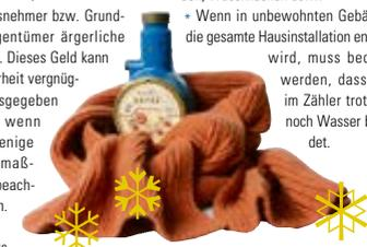
+ Wenn in unbewohnten Gebäuden die gesamte Hausinstallation entleert wird, muss bedacht werden, dass sich im Zähler trotzdem noch Wasser befindet.
