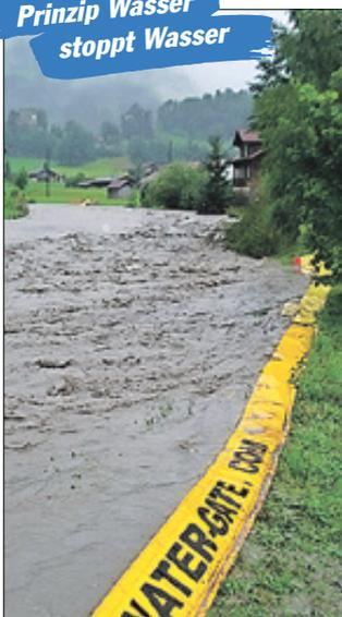
Water-Gate nutzt das Prinzip „Wasser stoppt Wasser“ und besteht aus geschickt angepassten PVC-Planen. Das Wasser fließt hinein und bewirkt, dass sich die Planen als Barriere selbständig entfalten und stabilisieren. Die Schutzhöhe beträgt bis zu 2m. Eine Rolle ist 15m lang und kann sofort tausende von Sandsäcken ersetzen. Die Barriere muss weder befestigt noch gefüllt, sondern einfach nur entrollt werden.
