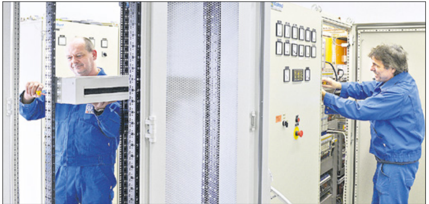
Eine Sache für Könner: Andreas Wehnert (links) und Uwe Bittoff bei der Erneuerung der Steuerung in der Kläranlage Lauchhammer.
