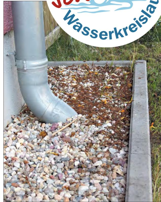
Bei Starkregen fallen schnell 30 bis 50 Liter Niederschlag pro Quadratmeter. Das bedeutet, dass von einem durchschnittlichen Dach mit 100m² Fläche bis zu 5.000 Liter Wasser entsorgt werden müssen. Die sollten von der Dachrinne nicht einfach auf den Boden rauschen. Die Gefahr einer Überflutung des Gartens wäre groß. Am besten führen Sie die Regenrinne direkt...
