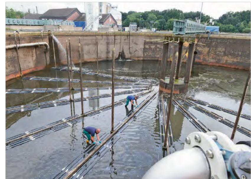
Herausfordernde Arbeit am Grunde der Belebungsbecken – die am Wechsel der Membranbelüfter beteiligten Kollegen sorgten mit großer Einsatzbereitschaft dafür, dass die Zeitvorgaben eingehalten wurden und die Briesker Kläranlage in möglichst kurzer Zeit zum Normalbetrieb zurückkehrte.
