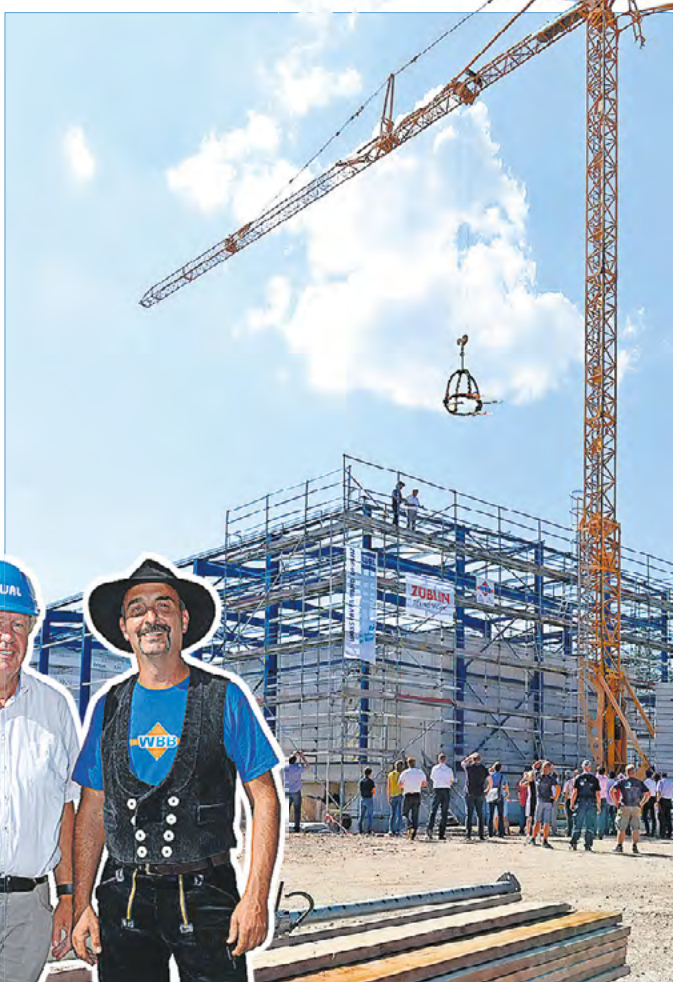
WAL-Vorsteher Dr. Roland Socher mit Thomas Paul, Polier des Baubetriebs. Das Richtfest für den Erweiterungsbau war Auftakt zum Schlussputz für die Fertigstellung der landesweit größten Aufbereitungskapazitäten für Trinkwasser.
