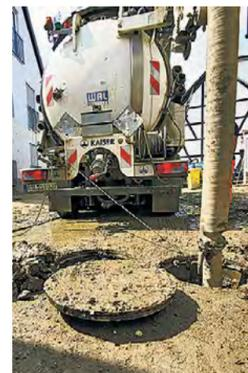
In noch fast menschenleeren Orten half das Spezialfahrzeug von WAL-Betrieb vor allem bei der Freiräumung von Regen- und Abwasserkanälen.
