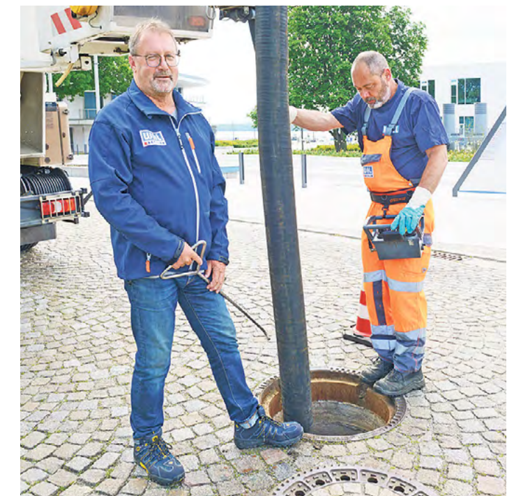
Jürgen Drost (l.) an einem Schacht: Im Interesse der Anwohner werden wo immer es geht Deckel gegen Klappergeräusche und den Austritt von Faulgasen abgedichtet.
