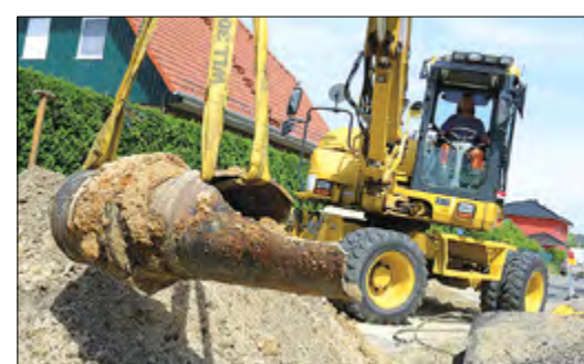
Da haben wir den Schuldigen – bei so einem Bruch schießt viel Wasser ins Umfeld.
