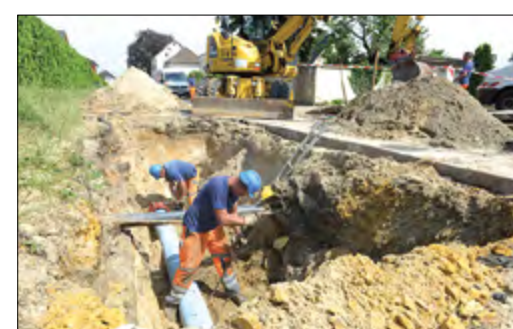
Die Lücke ist geschlossen, das Trinkwasser nimmt bald wieder seinen Weg.
