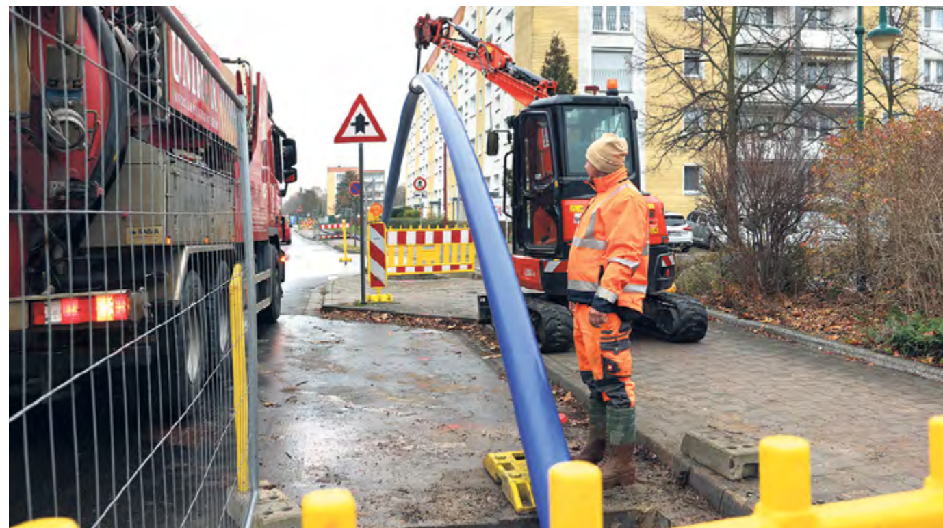
Plan und Flexibilität: In der Hanseatenstraße in Senftenberg werden für rund 300.000 Euro neue Trinkwasserleitungen verlegt. Dieses Vorhaben stand ursprünglich gar nicht im Investitionsplan 2021. Nach vier Leitungsschäden in relativ kurzer Zeit hat der WAL-Vorstand dem Leitungsneubau in dem Problembereich sehr kurzfristig zugestimmt.
