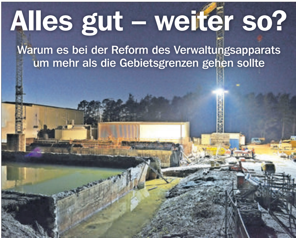
Endlich Licht am Ende des Genehmigungstunnels – am Wasserwerk Tettau wird gebaut. Foto: SPREE-PR/Rasche
