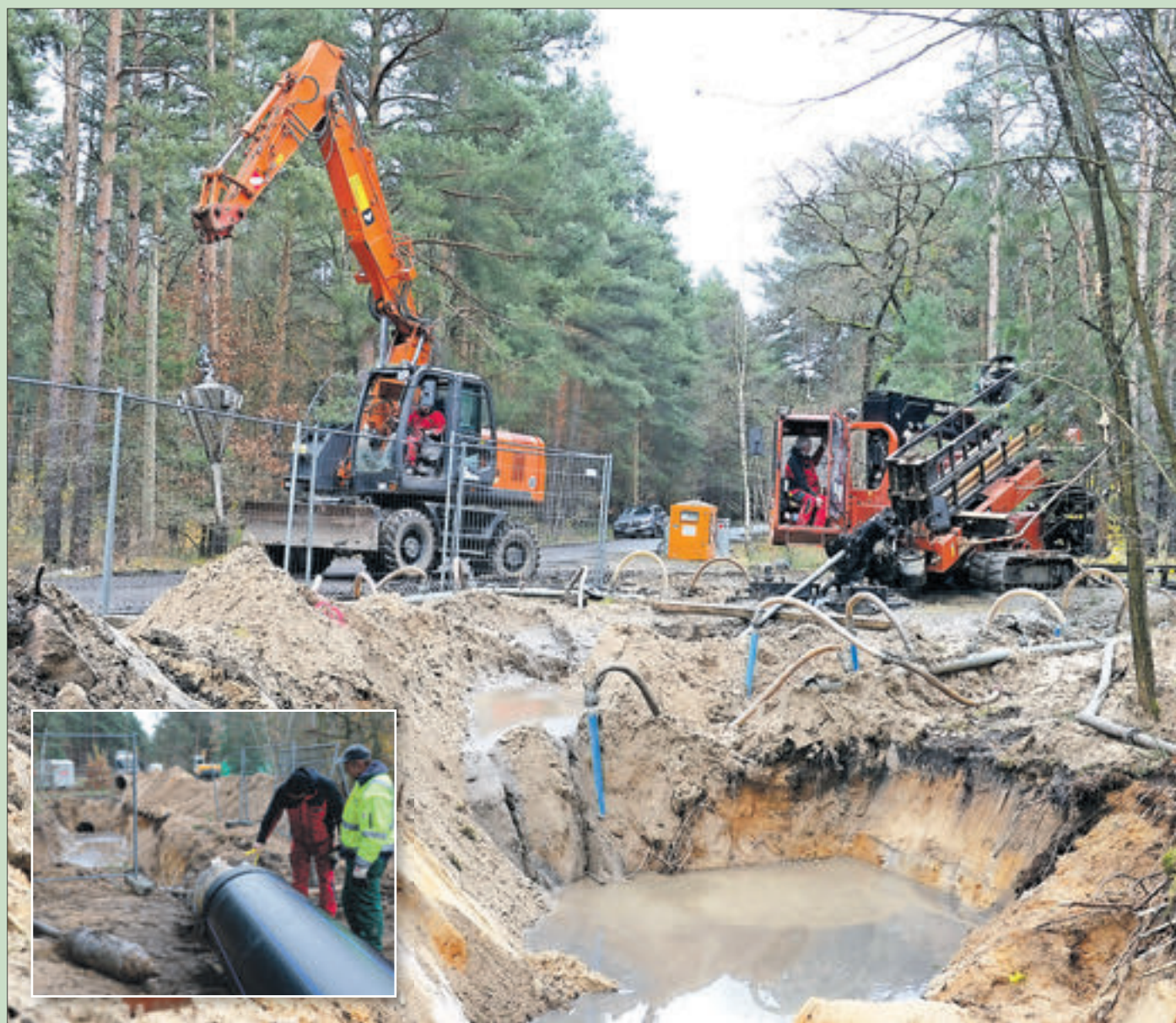
Mit hohem Aufwand wurde im November der Düker unter dem Sieggaben bei Ruhland erneuert: Stahl raus – haltbares PE rein. Fotos: SPREE-PR/Rasche
