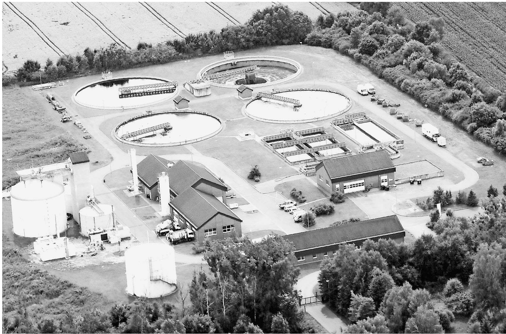
Die Kläranlage im Senftenberger Ortsteil Brieske ist die größte ihrer Art im Oberspreewald-Lausitz-Kreis. Ausgelegt ist sie für die Abwasserbehandlung von bis zu 60 000 Einwohnern. Die Anlage ging 1996 in Betrieb.
