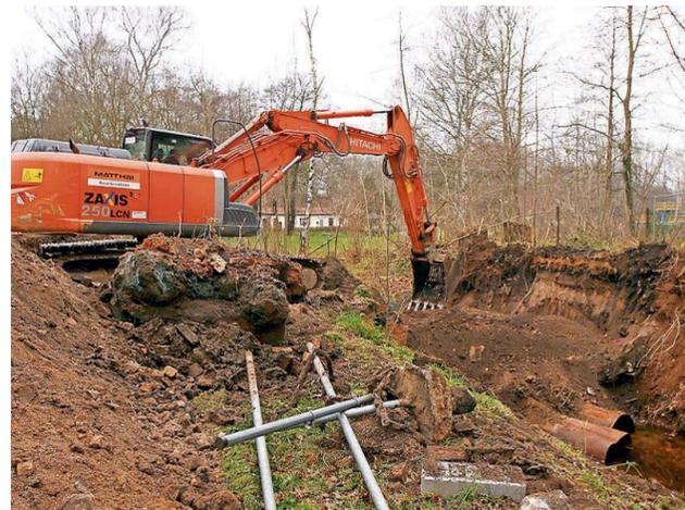
Mit schwerem Gerät reißt die Firma Matthäi aus Freienhufen die marode Brücke am Mittelweg in Höhe des Strandbades in Lauchhammer ab. Dabei fallen rund 60 Tonnen Abrissmaterial an. Sobald es die Witterung im kommenden Jahr zulässt, soll diese Brücke mithilfe von Fördermitteln wieder neu aufgebaut werden.
