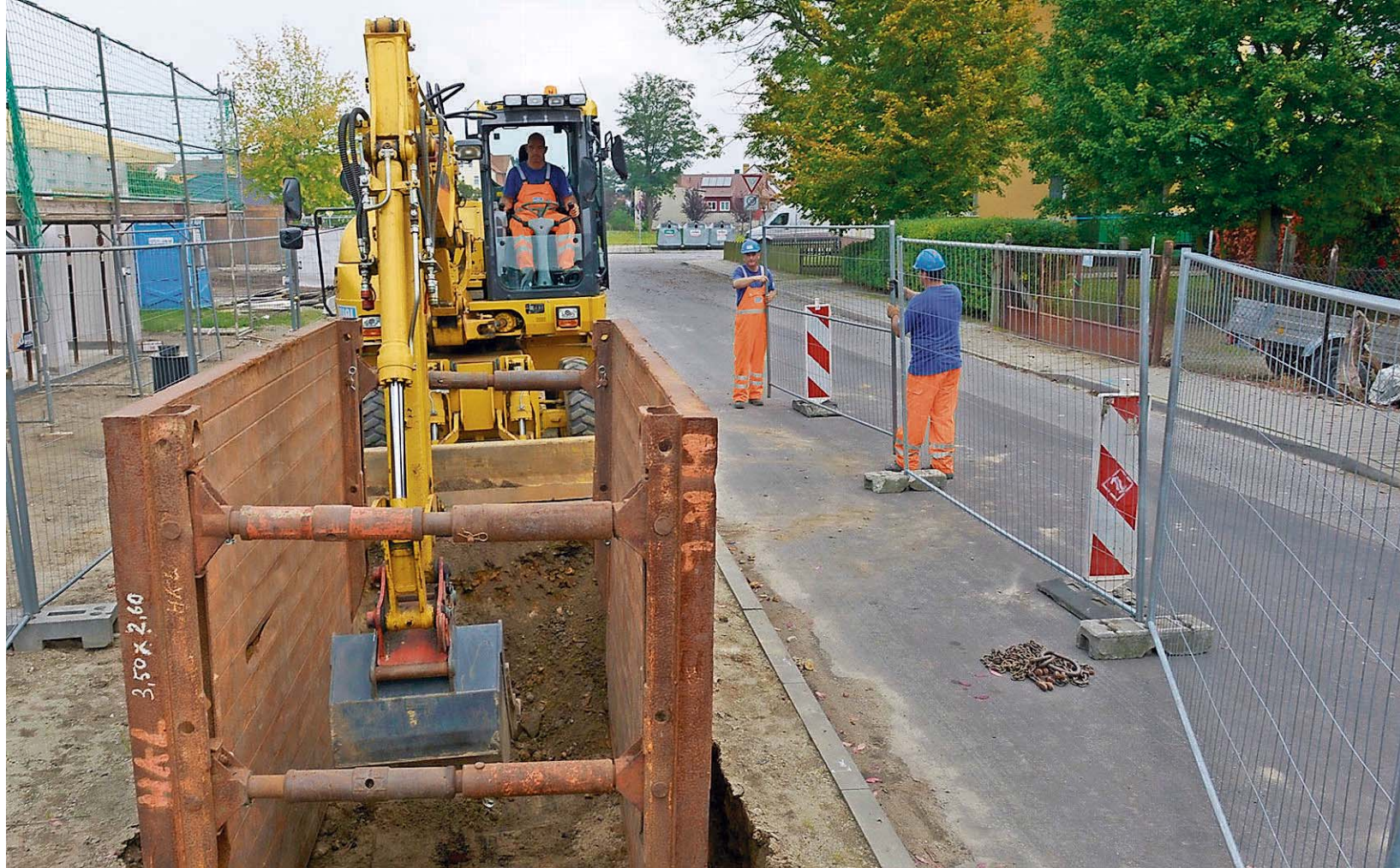
Die Stadt Senftenberg investiert kräftig, um die marode Regenwasserkanalisation auf Vordermann zu bringen. Der Kanal in der Friedensstraße wird jetzt erneuert. In den Wohngebieten Süd und am See werden die Hauptsammler seit dem Jahr 2011 schrittweise saniert. 500 000 Euro sind dafür auch im nächsten Jahr vorgesehen. Die Arbeiten werden allerdings insgesamt noch viele Jahre andauern. Foto: Steffen Rasche/str1
