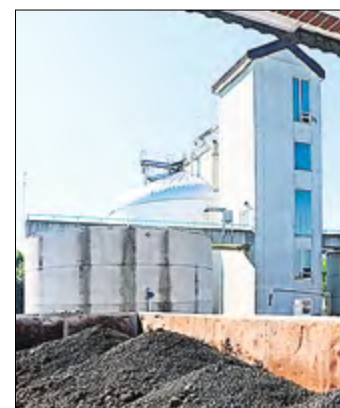
Der Klärschlamm wird in Containern zur Weiterbearbeitung gesammelt. Foto: WAL-Betrieb / Riska
