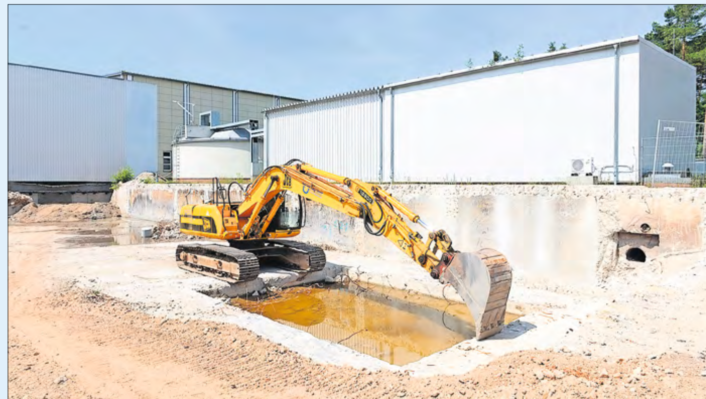
Auch der für den Bau bereitstehende Bagger lässt den Kopf hängen beim monatelangen Warten auf die Genehmigung zur Grundwasserabsenkung.
