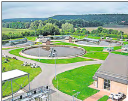
Das Becken-Diadem der Kläranlage.
