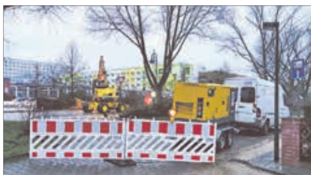
Mit Tagesanbruch sorgte ein beachtliches Aufgebot an Mensch und Technik für das Freilegen der gerissenen Leitung, für die Reparatur und die Wiederherstellung der Straße.
