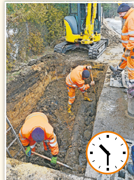
Ein Rohrbruch – da führt kein Weg am Aufschachten vorbei. Rund um die schadhafte Stelle musste die Leitung freigelegt werden (Bild links). So ist es häufig: Kein riesiges Loch, und doch tritt unter hohem Druck durch kleine Lecks schnell viel Wasser aus (Mitte). Die altersschwache Muffe zerfiel beim Herausnehmen gleich in zwei Teile (rechts).
