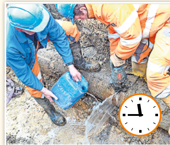
Das sofortige Binden des von der Trennscheibe verursachten Staubs ist strenge Vorschrift.
