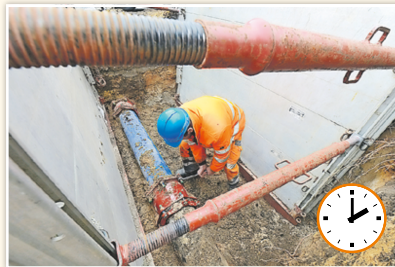
Mit der Befestigung der Muffen am neu eingesetzten Rohrstück ist die prinzipielle Funktionstüchtigkeit der Leitung wiederhergestellt. Nun muss noch entlüftet werden.
