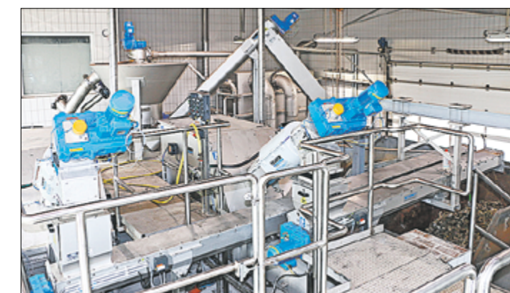
Vor der biologischen Reinigung müssen die Grobstoffe aus dem Abwasser abgetrennt werden. Dazu sind sogenannte Rechenanlagen im Einsatz. Nach knapp 20 Jahren Betriebszeit hatte die alte Technik auf der Kläranlage Brieske ausgedient und musste ersetzt werden. Da auch der Zulaufkanal schwere Korrosionsschäden aufwies (schlechte Betonqualität), wurde das Ganze sehr kompliziert und richtig teuer: 606.000 Euro.
