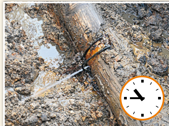
Ein Rohrbruch – da führt kein Weg am Aufschachten vorbei. Rund um die schadhafte Stelle musste die Leitung freigelegt werden (Bild links). So ist es häufig: Kein riesiges Loch, und doch tritt unter hohem Druck durch kleine Lecks schnell viel Wasser aus (Mitte). Die altersschwache Muffe zerfiel beim Herausnehmen gleich in zwei Teile (rechts).
