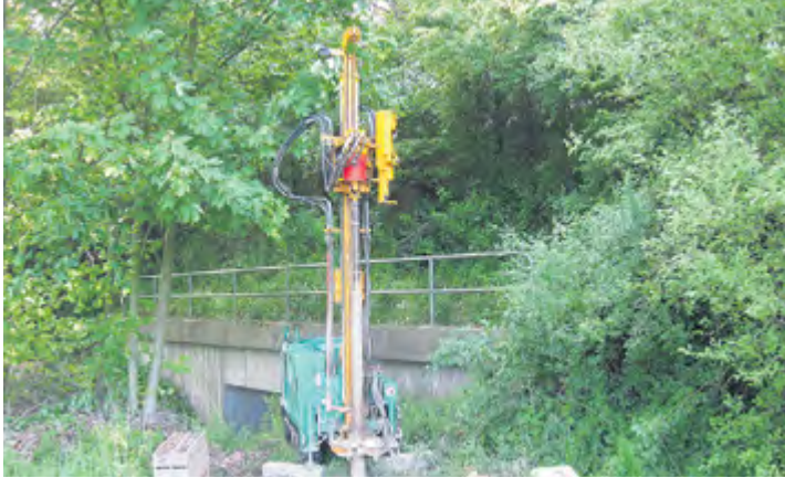
Wer bauen will, braucht sicheren Grund. Das gilt auch für Schmutzwasserkanäle und ganz besonders für die dafür notwendigen Schächte. Demnächst rückt diese Technik zur Baugrunduntersuchung auch in Klettitz an. Dort ist der Untergrund bekanntermaßen recht schwierig. Wenn alles weiter planmäßig läuft, werden die Tiefbauarbeiten schon im nächsten Jahr starten.
