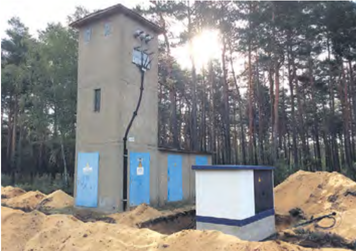
Die vier alten Trafostationen auf der großen Brunnentrasse östlich des Wasserwerks Tettau haben nach 44 Betriebsjahren ausgedient und wurden durch Transformatoren neuester Bauart ersetzt. Das dient der weiteren Betriebssicherheit und wird den aktuellen Vorgaben zur Arbeitssicherheit gerecht.
