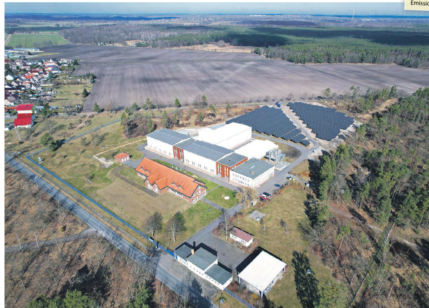
Für Rad- und Autofahrer verdeckt von den freundlichen Fassaden des neues Wasserwerks, aber aus der Vogelperspektive bestens zu erkennen: die ökologisch und wirtschaftlich segensreiche Fläche der Photovoltaik-Anlage. Ohne sinnvolle Bebauung bot die Brache auf der Fläche des alten Wasserwerks einen recht tristen Anblick. Nun werden hier Sonnenstrahlen gesammelt und übers Jahr 30 % des Energiebedarfs des Wasserwerks gedeckt.
