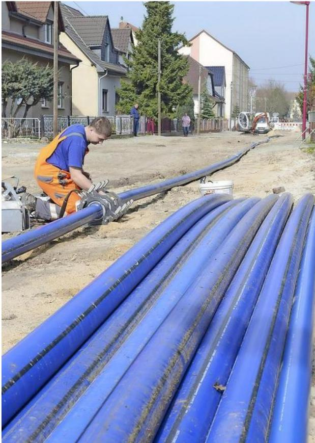
Die Bewohner der Großräschener Feldstraße sehen blau. Der WAL Betrieb ist innerhalb des Straßenausbau dabei, neue Trinkwasserleitungen zu verlegen. Monteur Toni Werner verschweißt die blauen Kunststoffrohre, die später im Unterbau der Feldstraße verschwinden. Foto: Steffen Rasche/str1
